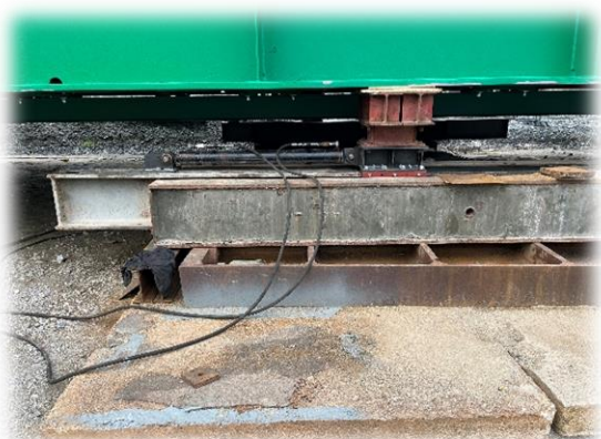
Obrázok 1- Hydraulický lis umožňujúci výsuv mostu nad riekou Váh.
