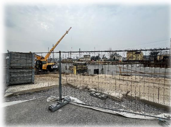
Obrázok 2- Prevedené práce na moste/podjazde na Kysuckej ulici.
