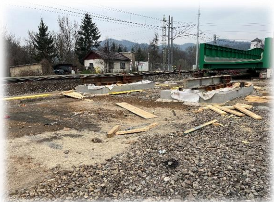
Obrázok 3- Behúne po ktorých sa most vysúva na podkladovom betóne.
