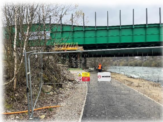
Obrázok 4- Podporná konštrukcia (pižmo) pod mostom ponad Váh pri Budatíne.
